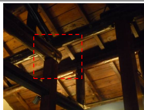
圖 4.4 樁接與鐵件接合處圖示
