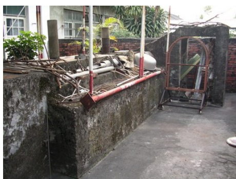
青島街110號防空洞，掩體上方還有設計兩根直立通氣管來使空氣流通
